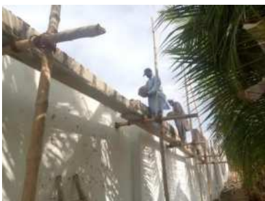
第3分校 学校を囲む塀を高くする工事中
