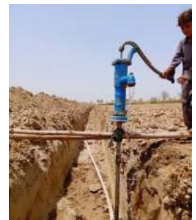
水を引くパイプの工事
