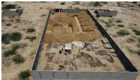
基礎工事中の新しい第4分校
